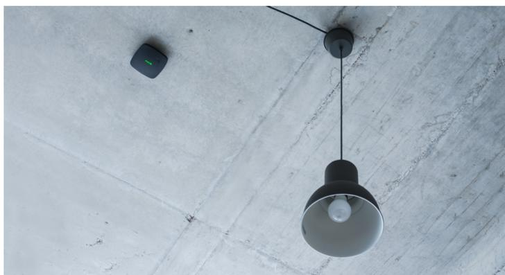
Le dispositif détecte la fumée à l'aide d'une caméra avec un capteur photoélectrique. Un élément chimique supplémentaire détecte le monoxyde de carbone et déclenche l'alarme.
